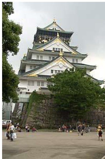
Links is nog net een lelijke lift te zien.
