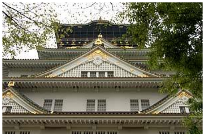
Een detail van het dak.
